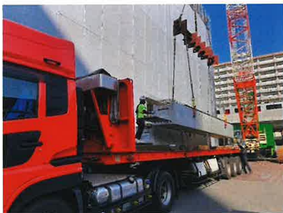
現場での荷卸し風景
